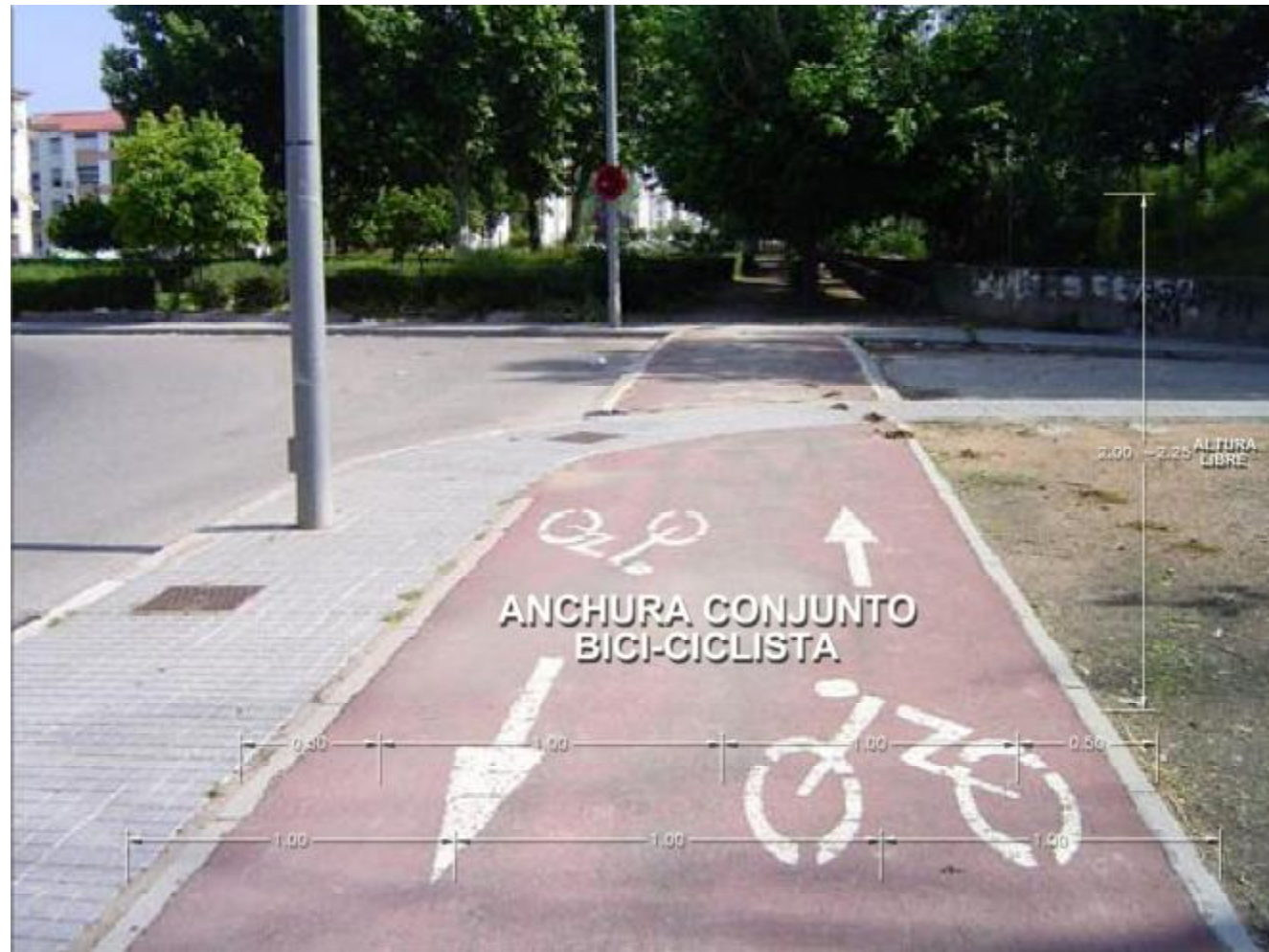
Imagen 28. Dimensiones óptimas en vías ciclables de dos carriles con doble sentido de circulación.
