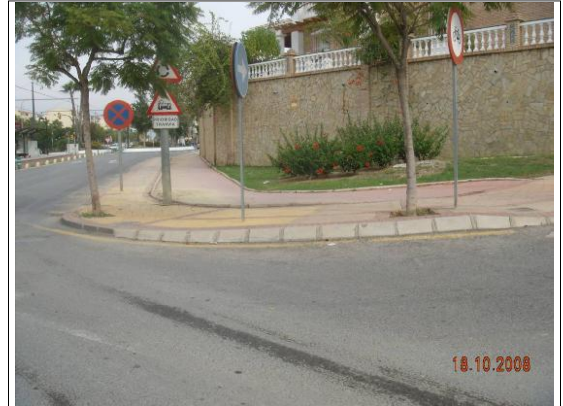
Fotografía 3 – Esta fotografía esta tomada en la intersección del camino del Higueral con la Avda. de Juan Carlos I. Vemos como el carril llega hasta el cruce.
