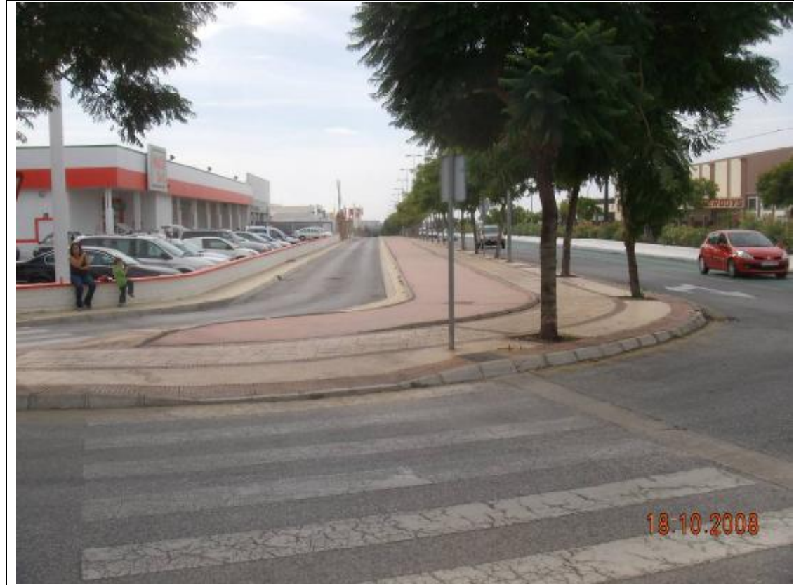
Fotografía 5 – Mirando hacia el sur vemos como el carril de bicicletas discurre entre la acera y la vía de servicio que le separa del polígono industrial.
