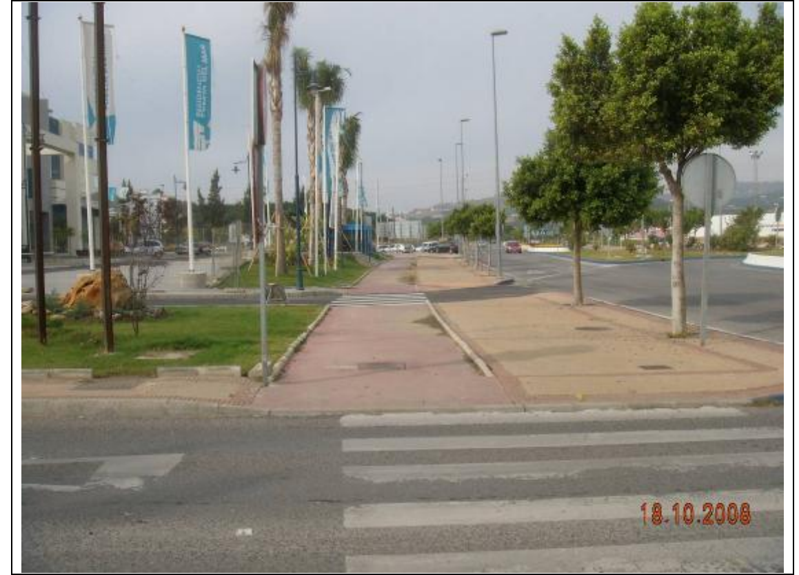
Fotografía 19 – Miramos ahora hacia el oeste y vemos como el carril construido nos posibilita llegar al campo de fútbol.
