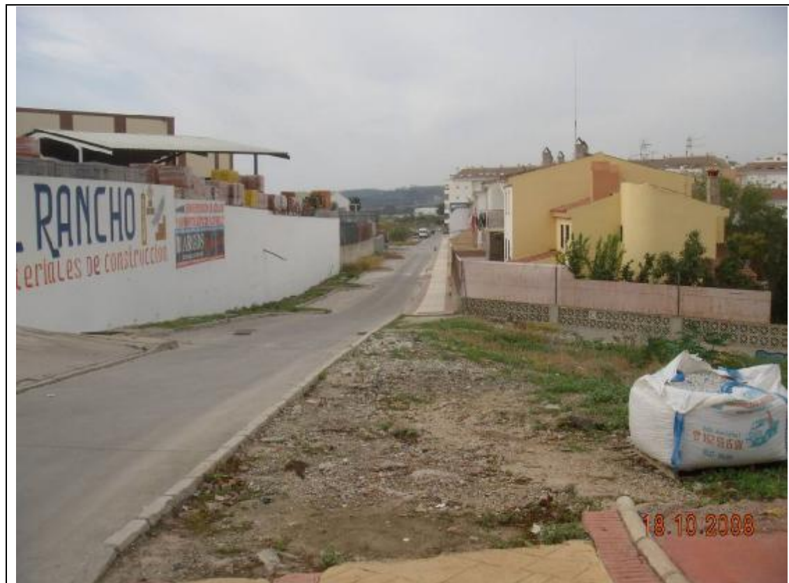
Fotografía 6 – En la zona oeste de la avenida de Juan Carlos I, también se construyó un carril de bicicletas. El continuarlo hacia la Avda. de Madrid por este vial, dada su estrechez, no nos ha parecido conveniente.
