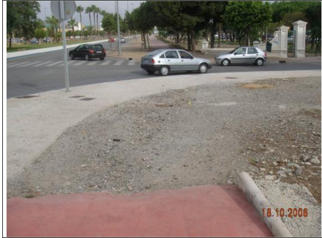
Fotografía 17 – Entre la posición anterior y la que ahora tenemos, en la que nos mantenemos mirando hacia el norte, vemos que falta la construcción de un pequeño tramo de carril.
