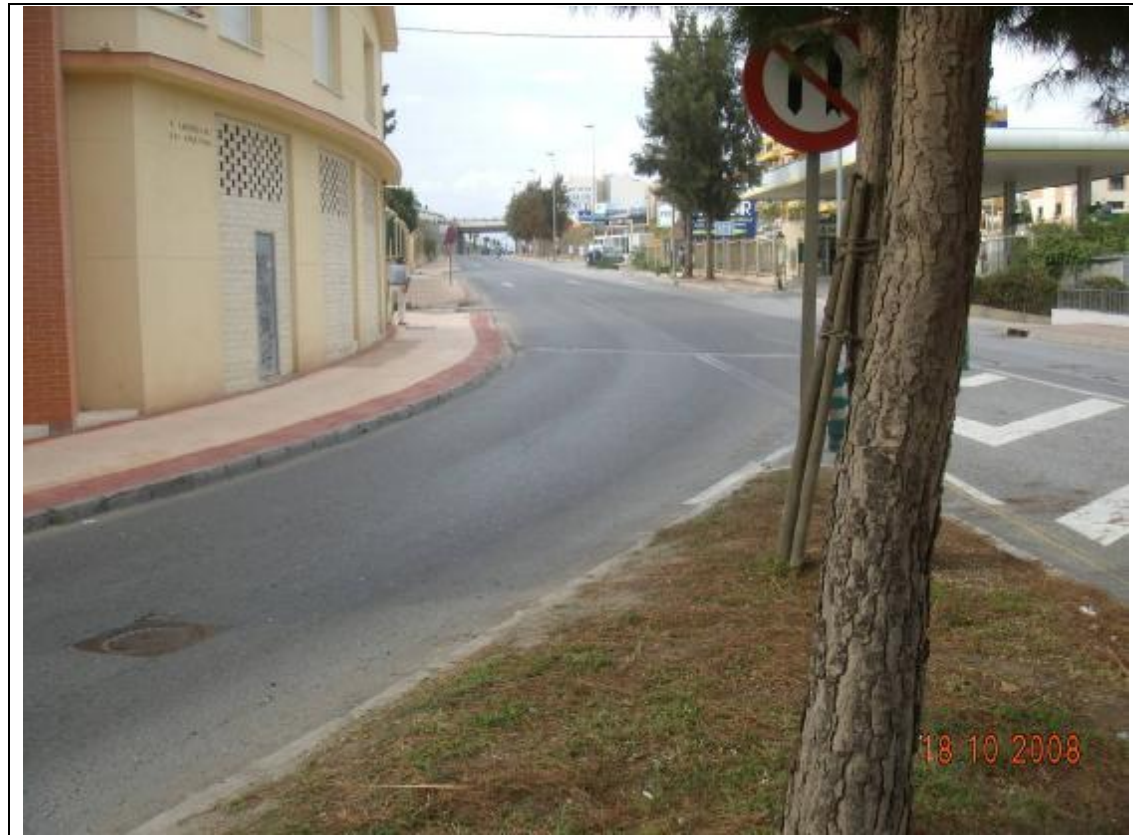
Fotografía 25 – Hemos llegado al final de nuestro trayecto. Estamos en la zona de trazado más complicado del mismo. Hay que compatibilizar un tránsito rodado complicado con la implantación de nuestro carril.
