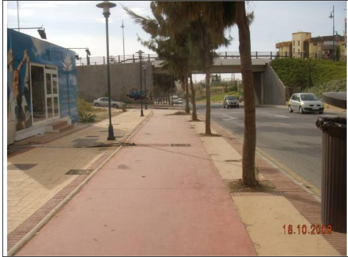
Fotografía 21 – El carril construido llega hasta la estructura que cruza sobre la Cuesta del Visillo.
