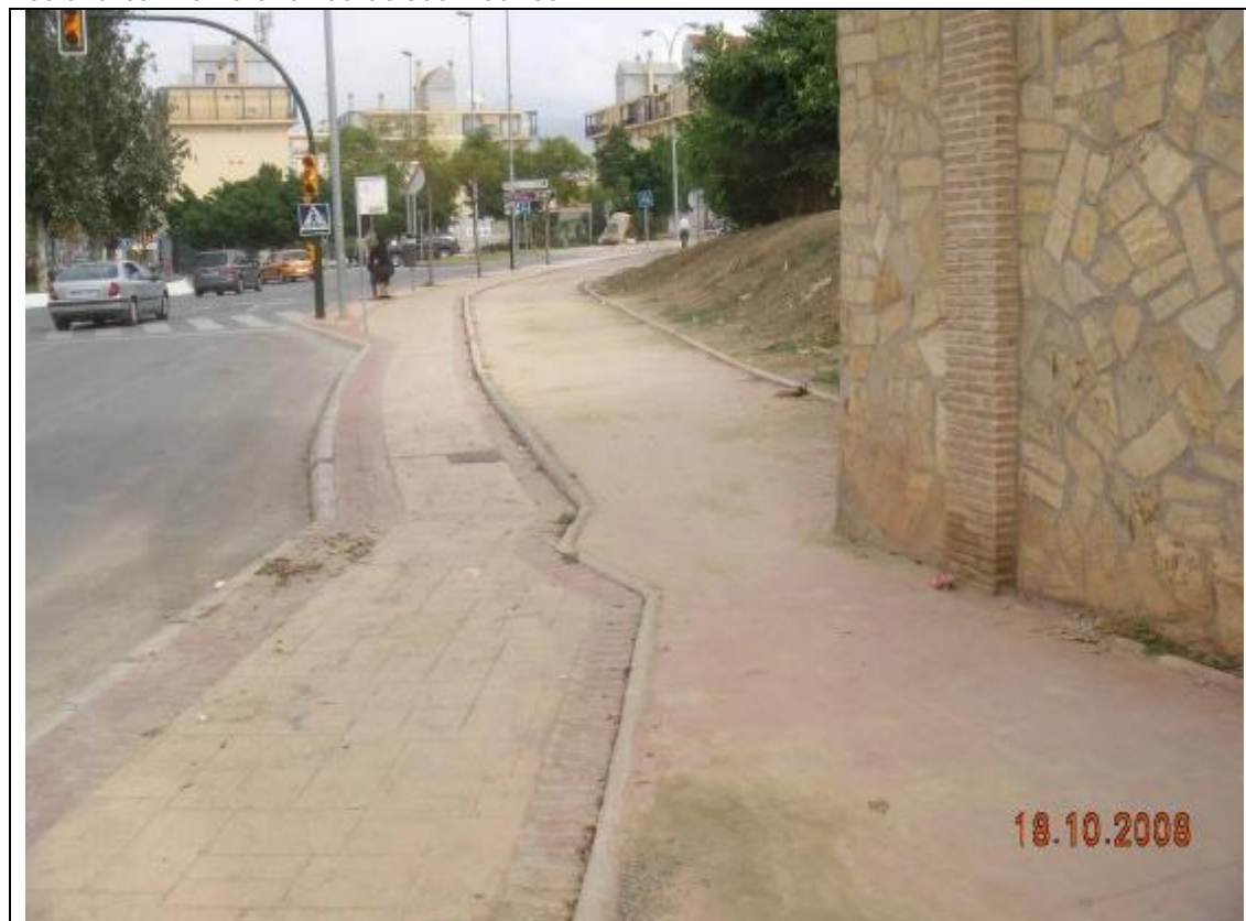
Fotografía 2 – Este es el único punto que, por existencia de una edificación, el carril, que es bidireccional, no tiene los prescriptivos 2,25 metros de ancho.
