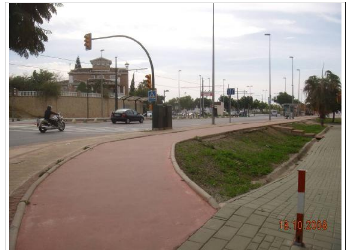
Fotografía 8 – Este es el extremo norte del carril que estamos mostrando. En la propuesta que hemos denominado "Unión transversal al sur de Vélez-Málaga" interconectamos todos los ramales que hemos mostrado en este entorno.
