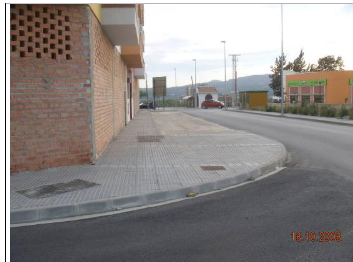
Fotografía 8 – Después de la zona verde la anchura existente entre la calzada y la fachada permite la implantación del carril, para lo que hay que cambiar el aparcamiento de batería a línea.
