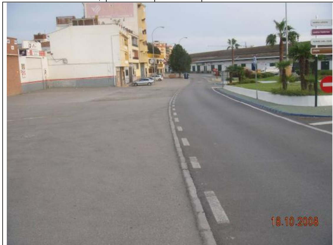
Fotografía 2 – No existe inconveniente, por la margen este de la antigua carretera, para implantar el carril.
