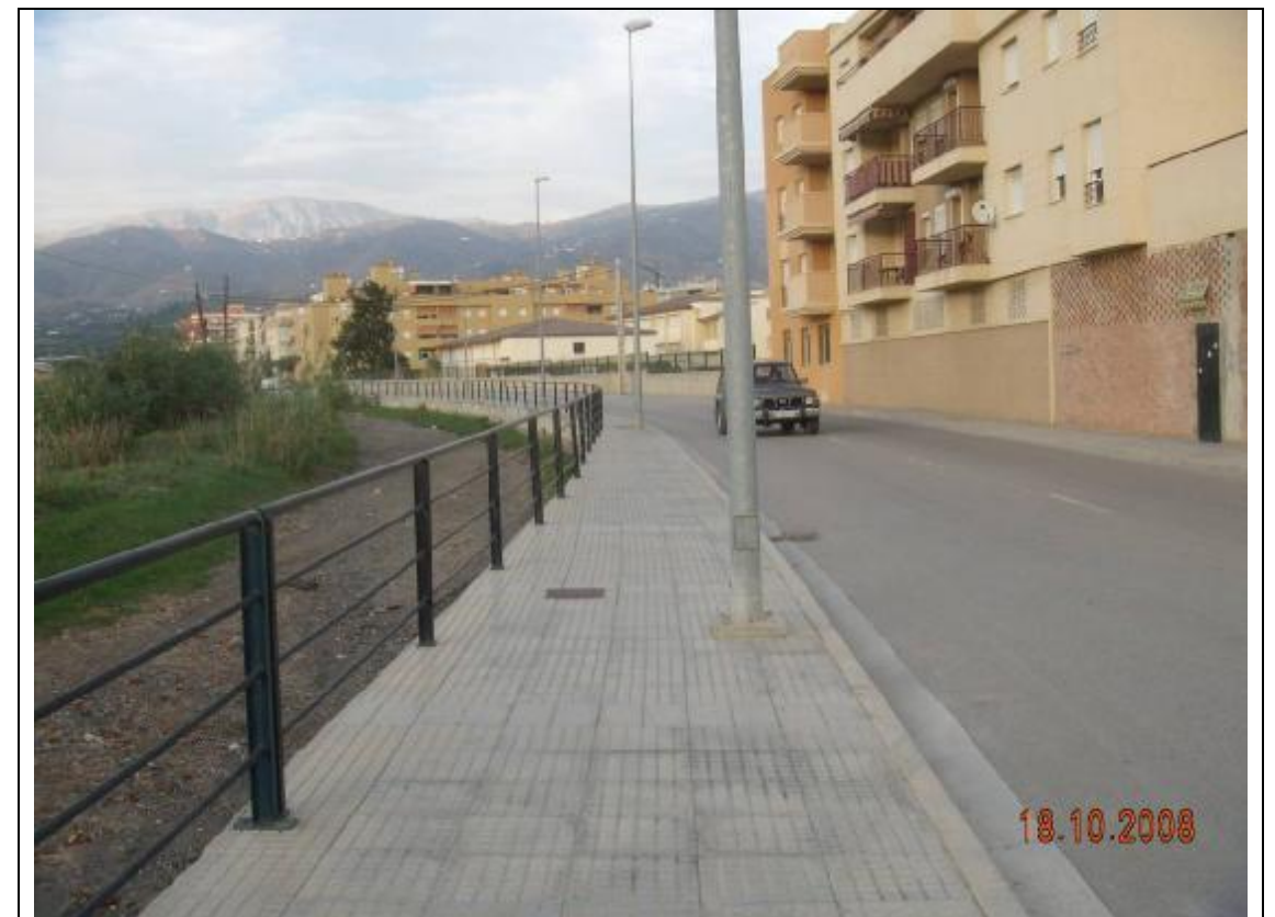
Fotografía 4 – En el primer tramo proponemos implantar el carril por la acera existente junto al arroyo del mineral. El tránsito peatonal no es necesario. Tendremos que disminuir algo el ancho de la calzada.
