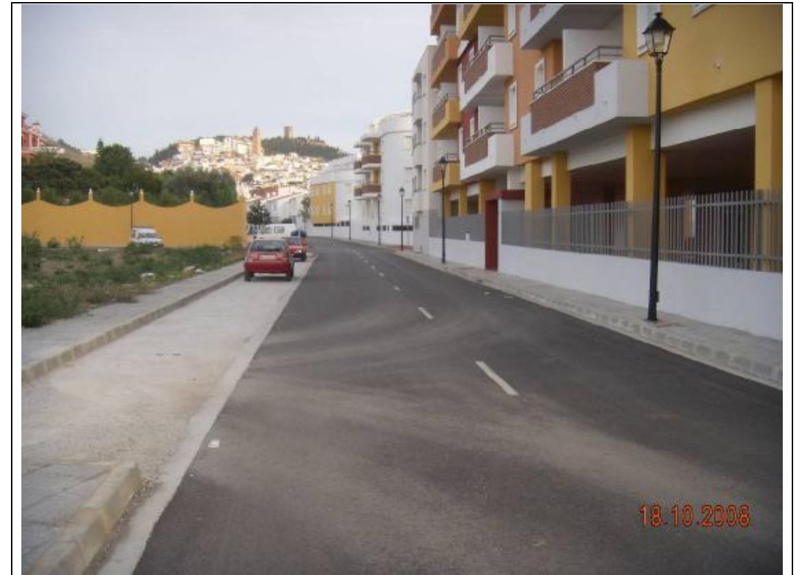
Fotografía 10 – La calle Transversal, nos conduce, con pendiente muy adecuada, hasta las proximidades de los Barrios Altos de Vélez-Málaga.
