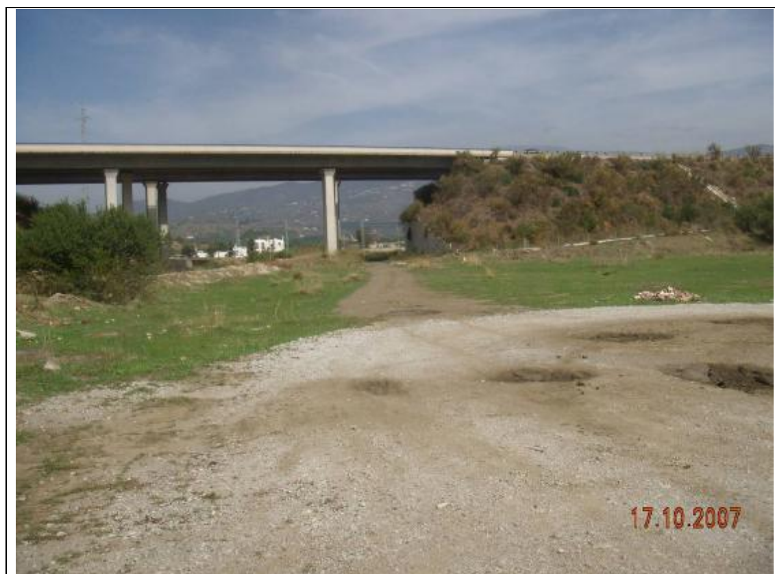
Fotografía 5 – Estamos en el límite norte del vial ya construido que mostramos en las siguientes fotografías. Vemos que no existe ningún inconveniente para implantar nuestro carril por este entorno.
