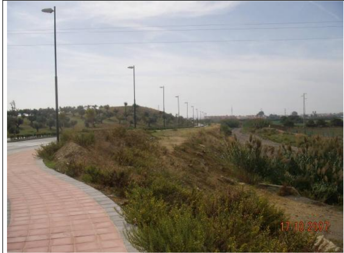
Fotografía 9 – Al sur de la rotonda volvemos a implantar nuestro carril en el lado oeste de la acera existente.
