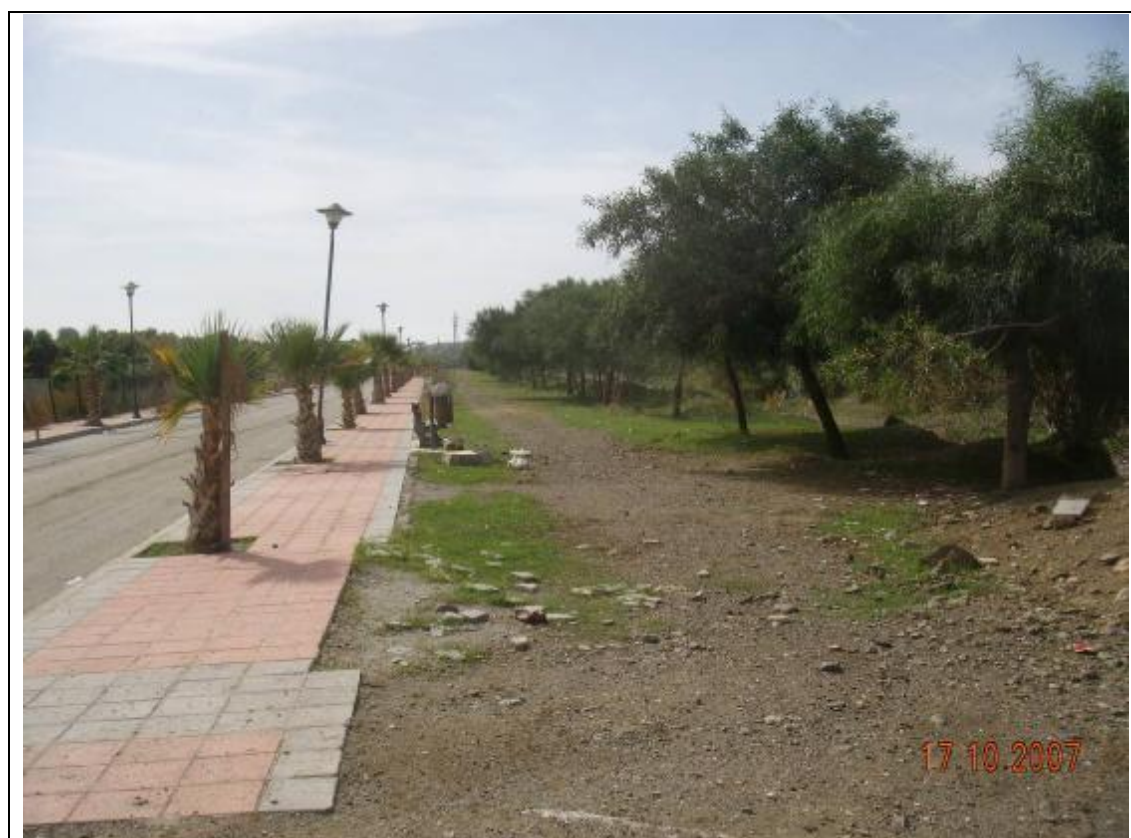
Fotografía 6 – A lo largo de todo nuestro recorrido, hasta al antigua CN-340, nos encontramos con una sección semejante: un vial construido y una plataforma sensiblemente plana entre el mismo y el cauce del río, por este espacio pretendemos implantar nuestro carril.
