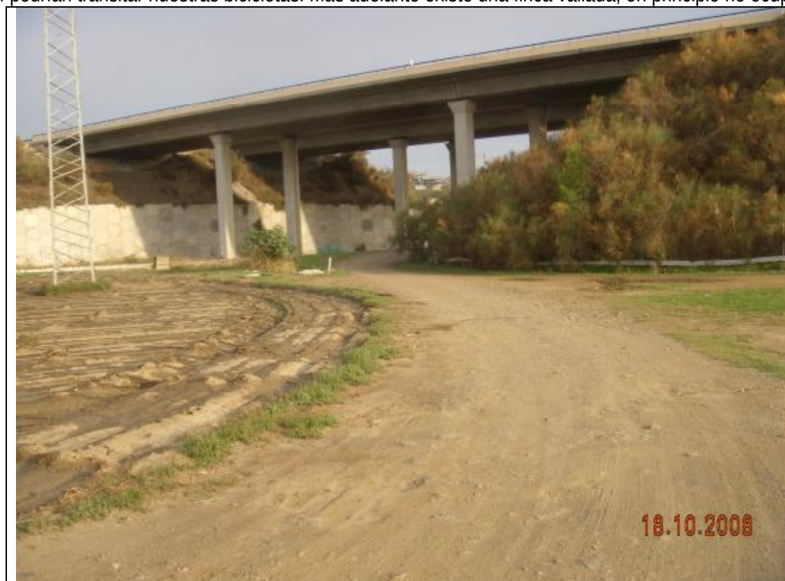
Fotografía 2 – No existe problema en transitar por debajo de la estructura para conectarse con el carril que proponemos junto a ella, en su lado sur, que hemos denominado “Transversal al Norte de Torre del Mar”
