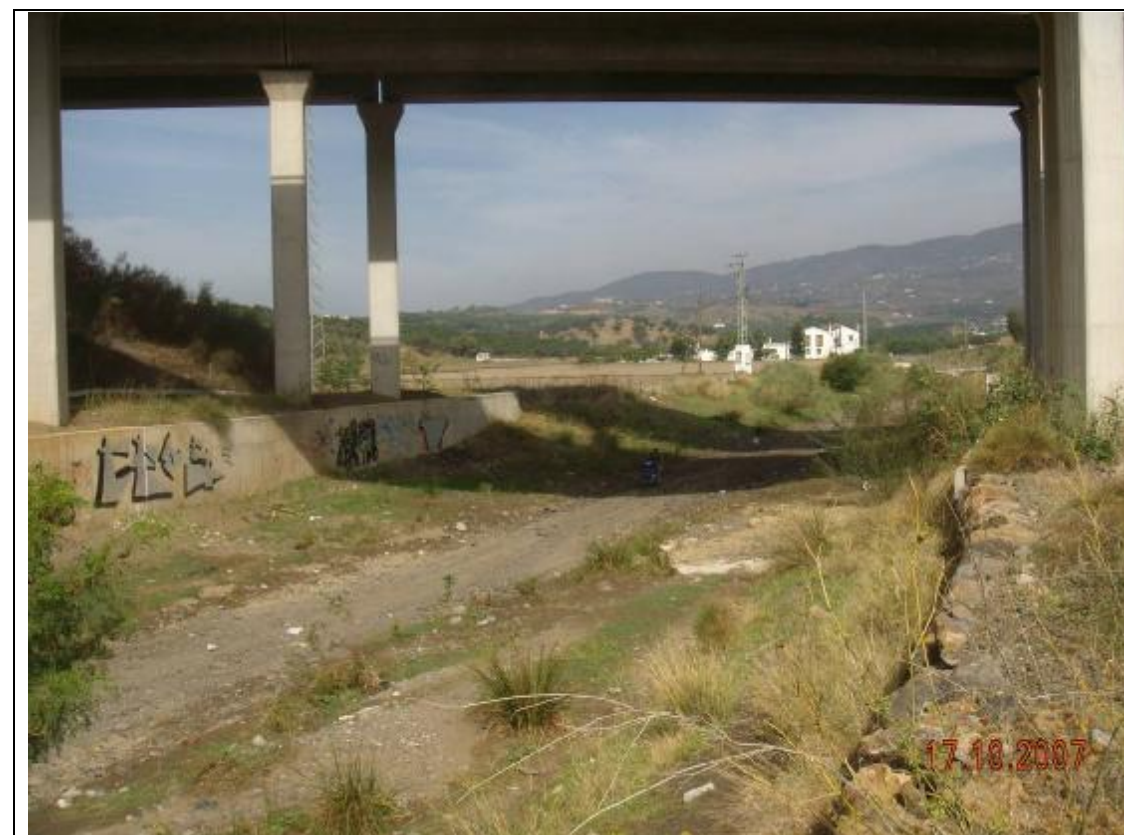
Fotografía 3 – Desde la otra margen, del río Seco, la este, miramos el carril por el que nos hemos desplazado. En este entorno hay que proyectar una pasarela para que nuestro carril pueda cruzar el río.
