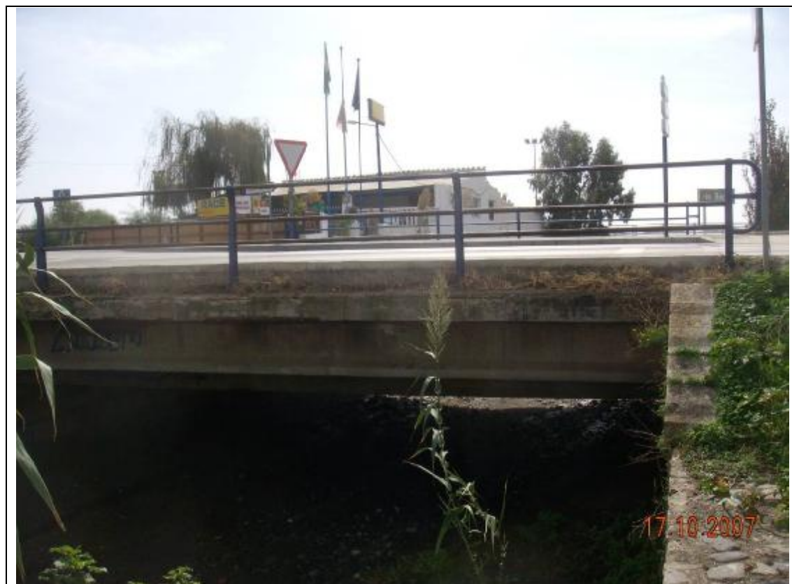
Fotografía 13 – Mostramos el tablero con el que la CN-340 cruza por encima del río Seco, su luz aproximada es de quince metros.
